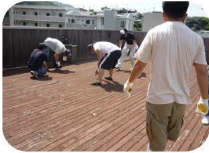
真夏の太陽の下、屋上のウッドデッキを 修理していただきました
